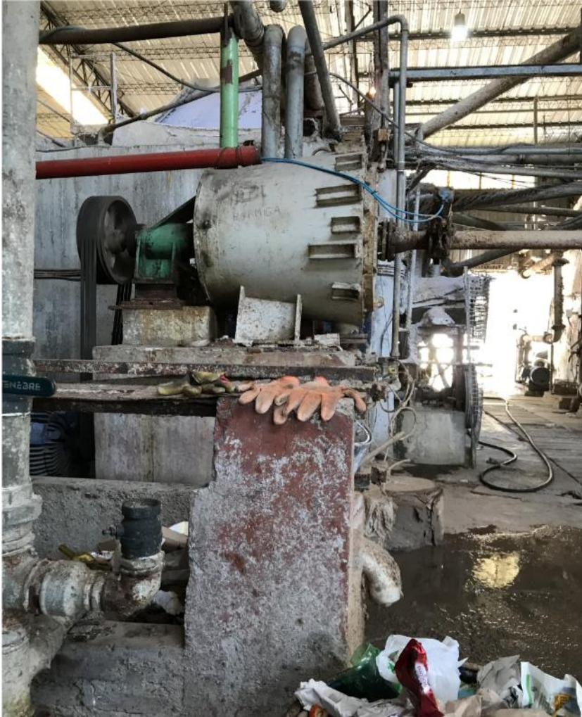
Figura 16. Ingreso a las tuberías para la pasta de papel kraft. Fotografía propia.
