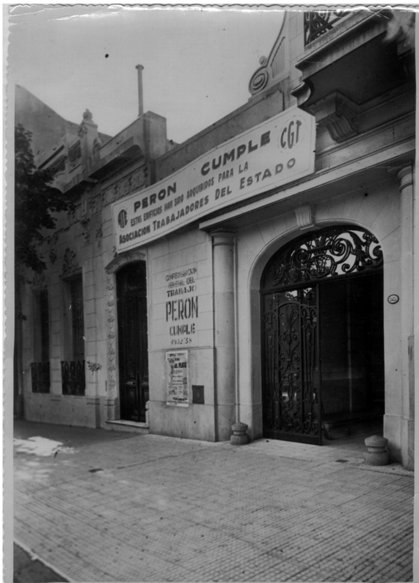
Antigua fachada de la sede del Consejo Directivo Central de ATE a poco de ser adquirida.
