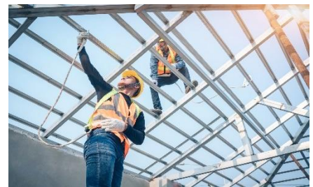
Imagen INEFOP, capacitación Instalación en Steel Framing
